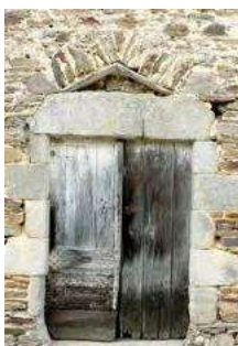
Détails de porte : linteau de granit et arc de décharge
