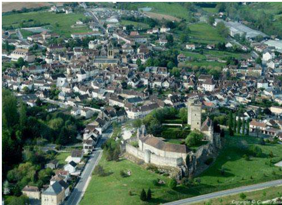
Exemple d'Excideuil et de son château. Source : Camille Beau, Survols de France
